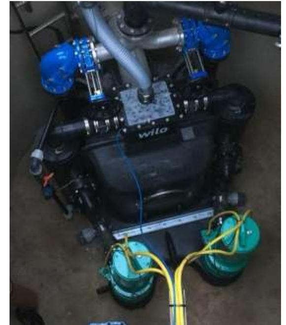
Als neue Anlage wurde sich für eine EMUport CORE aus dem Hause Wilo entschieden, die im vorhandenen Betonschacht DN 3000 eingebaut wurde. Diese neue Anlage ist weitgehend aus rostfreien Komponenten (PEHD, Edelstahl) gefertigt und garantiert damit eine lange Standzeit. Als Pumpen kommen trocken aufgestellte Abwassertauchpumpen zum Einsatz.
